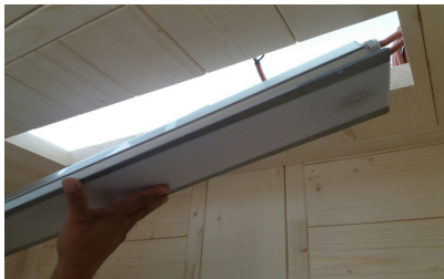
Fig. 45 : Montage lampe couleur
