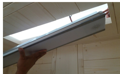
Fig. 46: Montagem da lâmpada colorida
