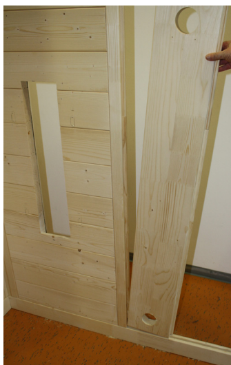
Fig. 6: Inserimento dell'elemento elettrico
