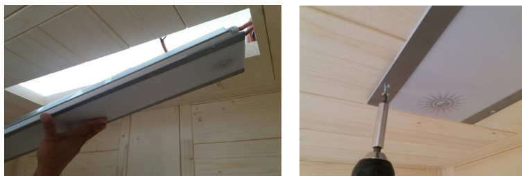
Fig. 45: Montaggio della lampada a colori
