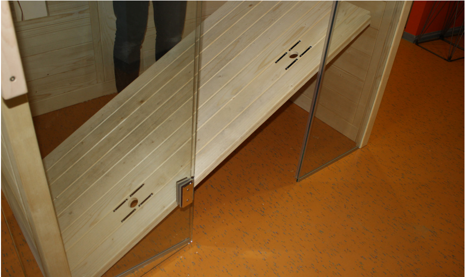
Fig. 27 : Poser le plancher de la cabine
