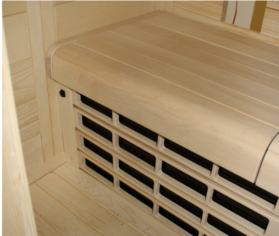
Fig. 36 : Pose du banc
