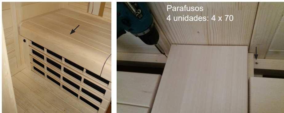
Fig. 47: Fixação do banco
