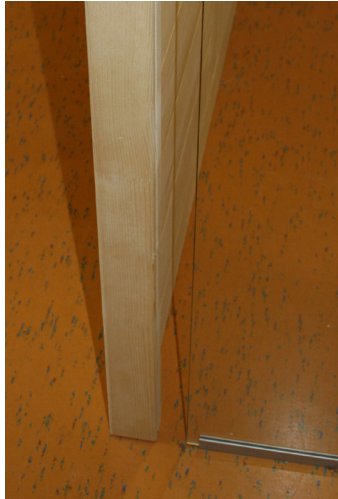
Fig. 12: Inserimento della lastra di vetro nella scanalatura del montante angolare
