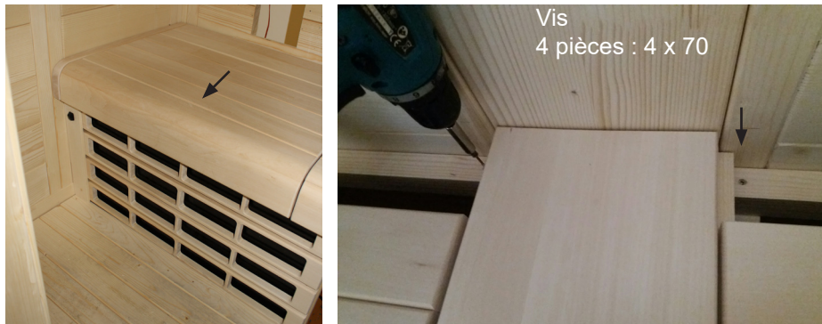
Fig. 46 : Fixation du banc
