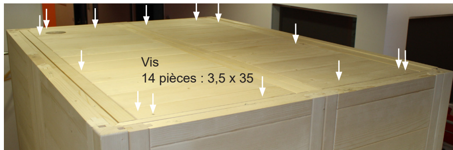
Fig. 19 : Fixation des éléments de toit
