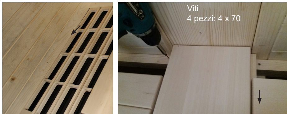
Fig. 46: Fissaggio della panca
