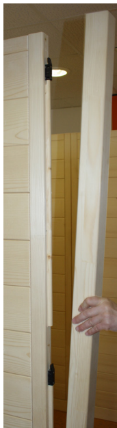
Fig. 9: Montagem dos dois suportes de canto frontais com ranhura para vidro
