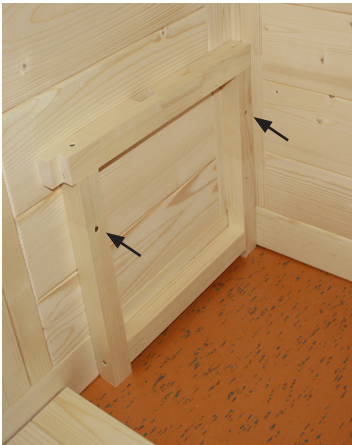
Fig. 32: Montagem do apoio do banco
