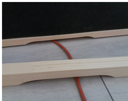
Fig. 34 : Insertion de la bande de renfort pour plaques chauffantes IR VitaMy
