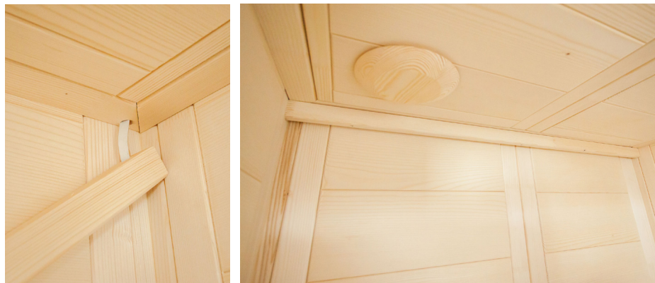
Fig. 42: Fissaggio del listello a LED
