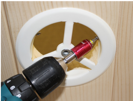
Fig. 35: Montaggio della ventilazione
