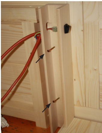
Abb. 32: Montage der U-Leisten für Wärmeplatten
