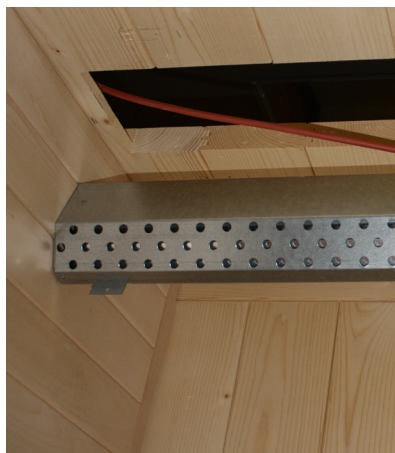
Fig. 37: Montaggio degli irradiatori posteriori (irradiatore a infrarossi ECO 350)
