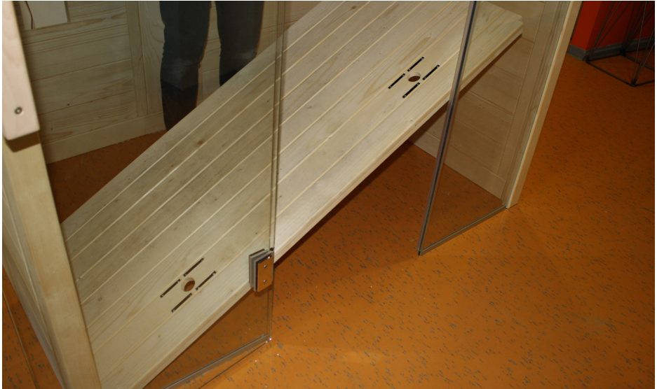
Fig. 27: Inserimento del pavimento della cabina
