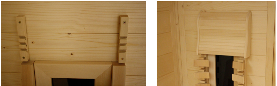
Abb. 48: Montage Kopfstützen
