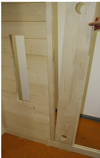
Fig. 6: Instalar o elemento elétrico
