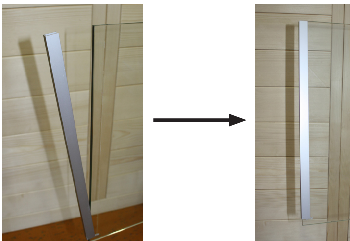
Fig. 11: Instalar os perfis em U nas placas de vidro
