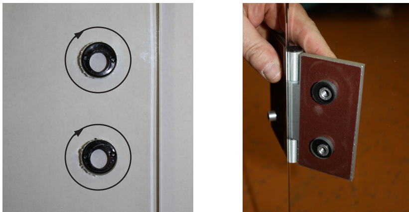
Fig. 22: Montagem das ferragens da porta 1
