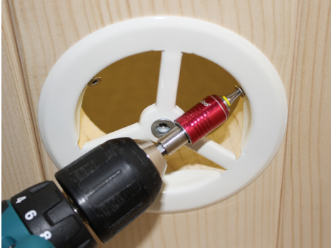
Fig. 35 : Montage de la ventilation
