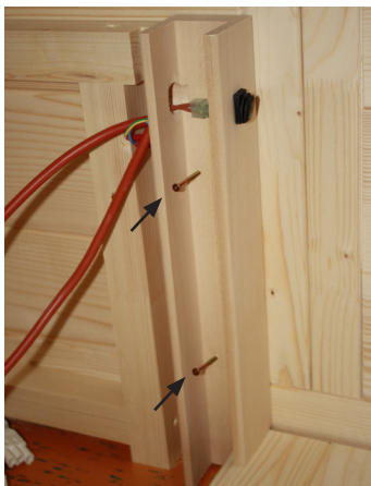
Fig. 32 : Montage des barres en U pour les plaques chauffantes
