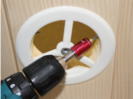
Fig. 36: Montagem da ventilação
