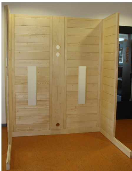
Fig. 7: Pannello posteriore montato
