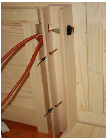
Fig. 33: Montagem das barras em U para pacas de aquecimento
