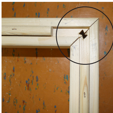
Fig. 2: Collegamento degli elementi del pavimento
