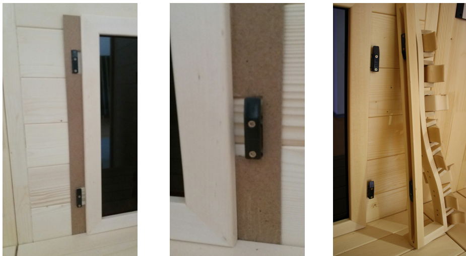
Fig. 50: Montagem dos encostos
