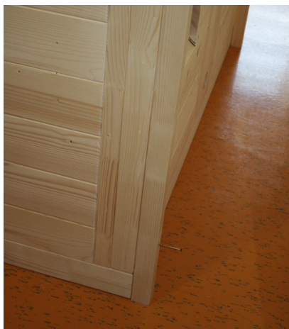
Abb. 47: Montage Abstandleisten Rückwand
