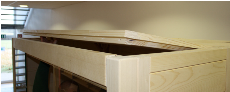
Fig. 18: Inserção dos elementos de teto da frente
