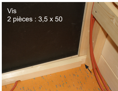
Fig. 34 : Insertion de la bande de renfort pour plaques chauffantes IR VitaMy
