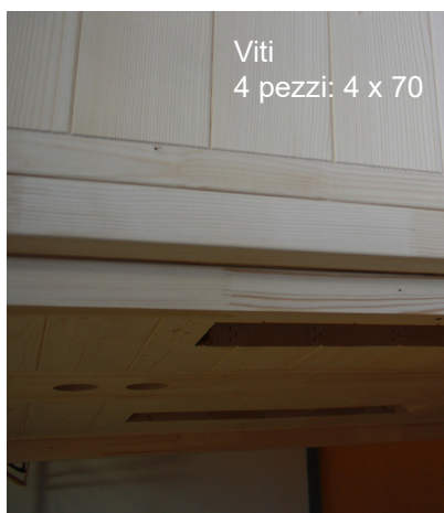
Fig. 47: Montaggio dei listelli distanziatori sul pannello posteriore
