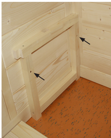
Fig. 31: Montaggio del supporto della panca
