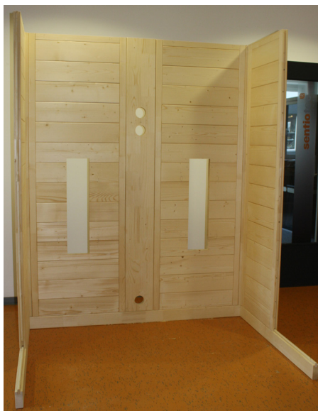
Fig. 7 : Paroi arrière montée
