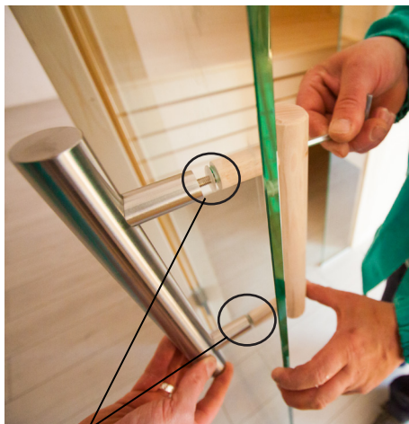
Applicare rondelle di plastica nelle maniglie Nirosta
