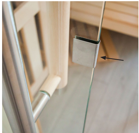
Kunststoff Beilagscheibe bei Niro-Griff beilegen
